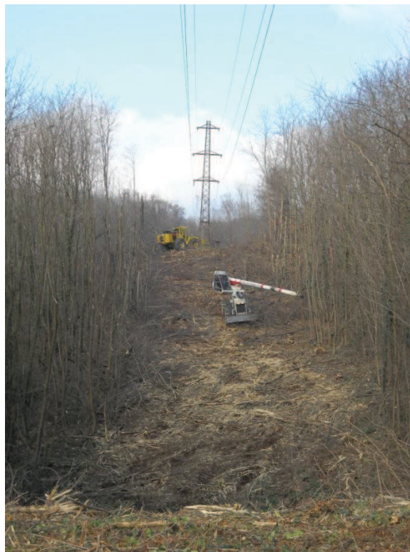
Elagage HTA : végétation repoussée à 5m en latéral, généralement broyée au sol ou ramenée à 3m en dessous de la ligne en propriété privée
